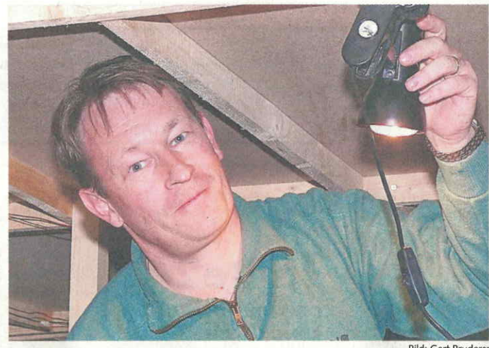
Markus Kästli bei der Arbeit am Unterbau. Darüber fahren auf einer Fläche von rund 200 Quadratmetern anfangs 12 bis 15 Züge.
